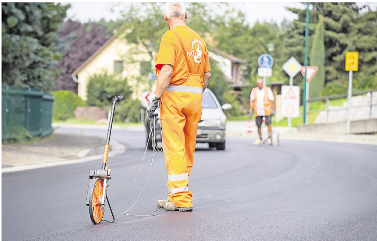
Peter Fräger und Maik Burkhardt zählen zu den Ersten, die die frisch sanierte B 115 zwischen Niesky und Rietschen wieder in Beschlag nehmen. Aber zu Fuß. Sie bereiteten am Donnerstag die Straßenmarkierungen vor. Foto: André Schulze
